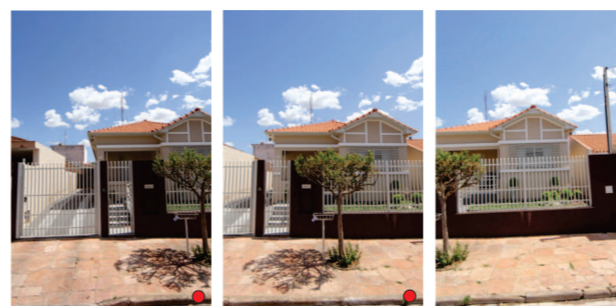
Levantamento fotográfico frontal georreferenciado
